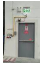
Install a fire door
