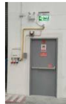
ติดตั้งประตุน้ไฟ
