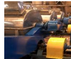
ติดตั้งการ์ดครอบจุดหมุนของเครื่องจักร
